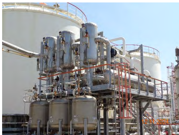
ภาพที่ 2.2-8 Vent Condensing Unit
