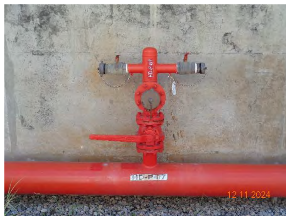
ภาพที่ 2.2-43 หัวจ่ายน้ำดับเพลิงทุกระยะ 40 เมตร
