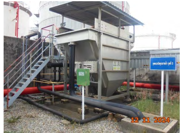
ภาพที่ 2.2-14 Oil-Water Separator
