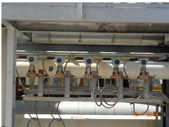
ภาพที่ 2.2-7 Pressure Transmitter
