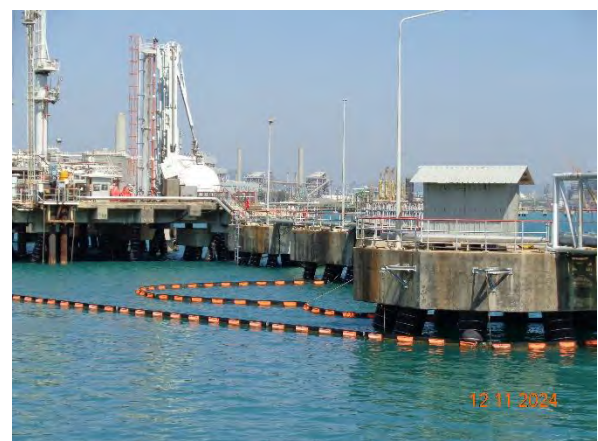
ภาพที่ 2.2-16 Oil Boom House และ Permanent Oil Boom
